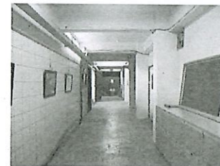
8.地點：萬有樓地下室
