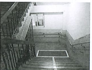
5.地點：育才樓地下室
